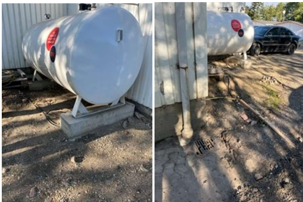
Foto 2-3: Ved læk fra tank placeret nær lade, er der risiko for afløb mod drænrist. Der bør laves jordvold eller lign. For at tilbageholde evt. spild.
