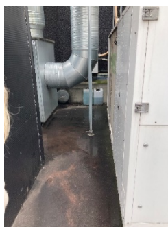
Figur 2: Billede af plastdunke stående udendørs, uden spildbakke og overdække.
