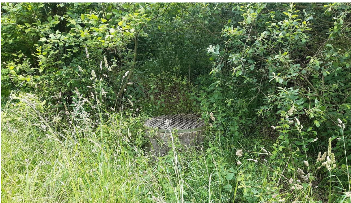
Figur 6: Brønd til spuling af perkolatsystemet
