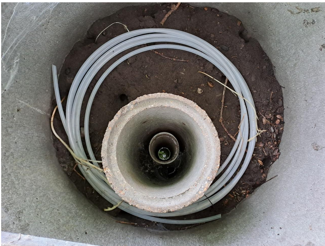
Figur 10: Grundvandsboring MO6 uden markering og med høj grundvandsstand
