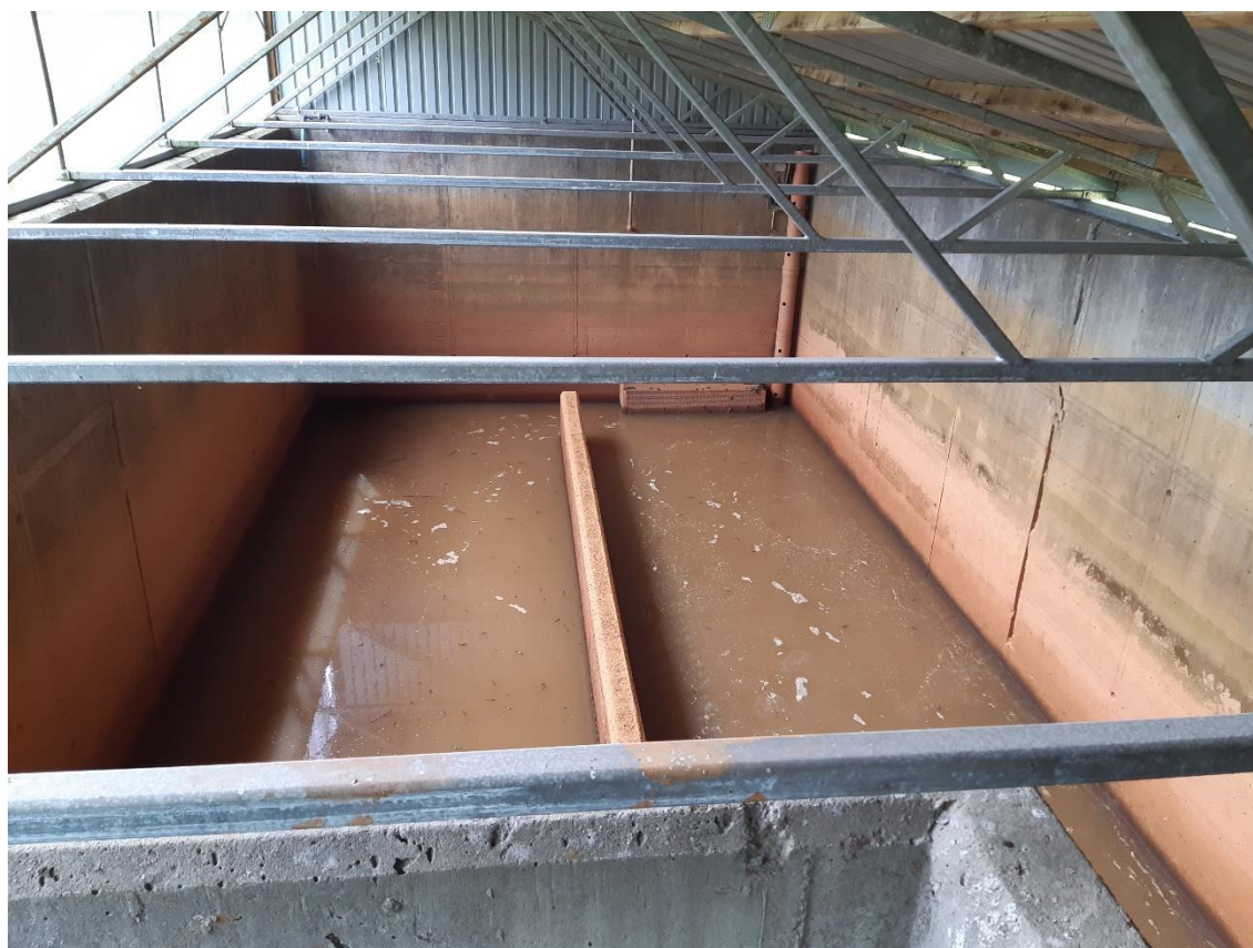
Figur 4: Overdækket perkolattank
