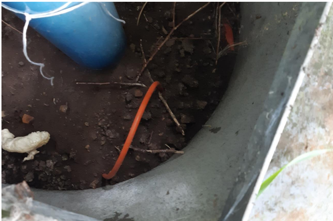
Figur 9: Ukendt ledning ved PU2
