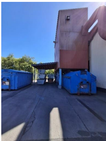
Filteranlæg til kabelhallen
