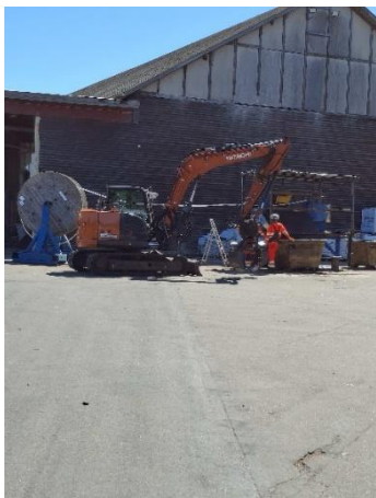
Cables udendørs klipning af store kabler
