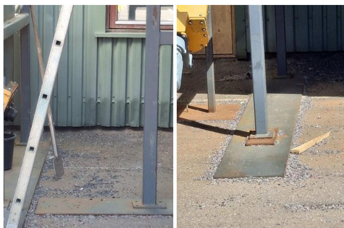
Spildt Cables-granulat ved udendørs del af vådsorteringsanlægget
