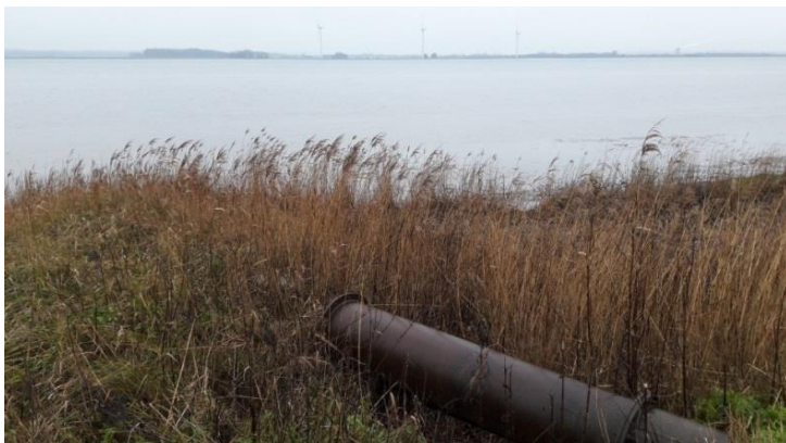
Foto 4. Rør, der gennemskærer diget i det sydøstlige hjørne af vestfeltet.
