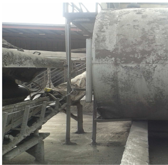
Fig. 3 To af tankene stikker uden for tankgården
