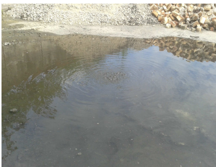
Fig.4 Opstigende vand fra afløb på blegejordspladsen
