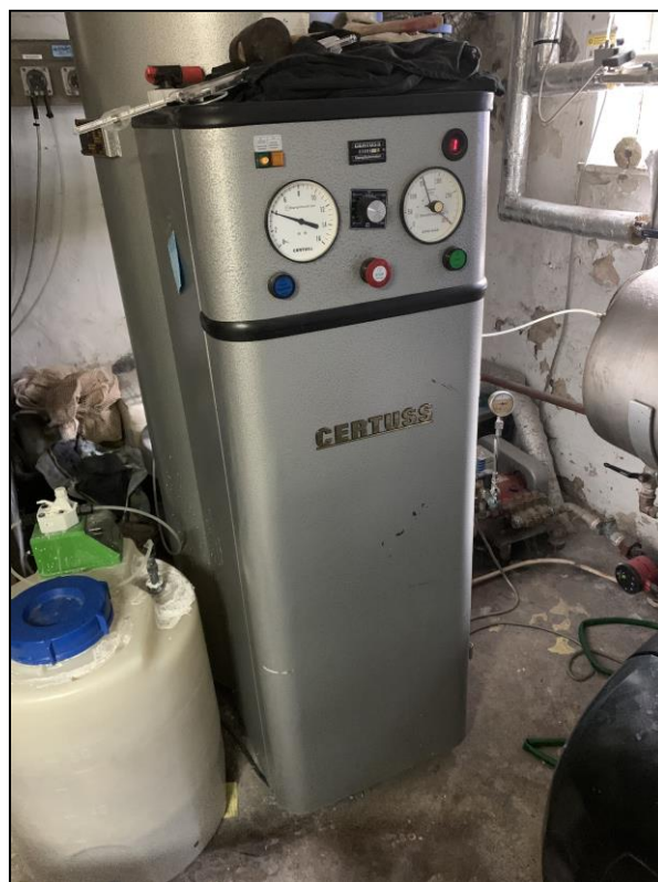
Blødgøringsanlæg (til højre) etableret i kælderen med vaskemaskine og tørretumbler. Foto fra tilsvn 2020
