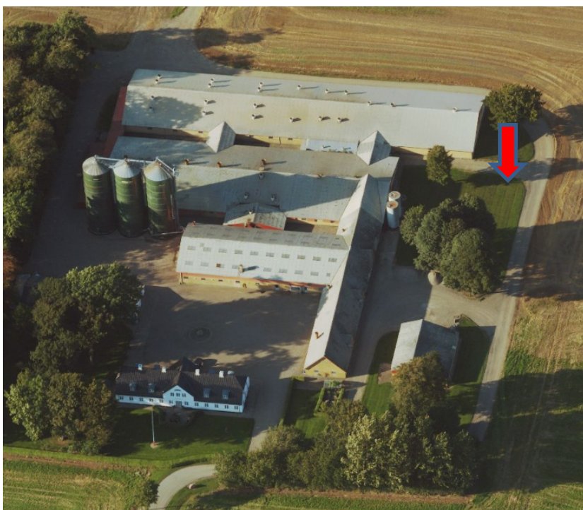
Fig. 1: Ny opsamlingsbeholder, se under rød pil.
