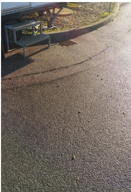
Reparation af asfalt ved holdeplads for tankvogne med diesel og spildolie
