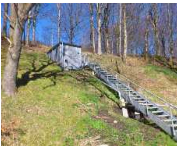
Trappe til tanktunnel.
