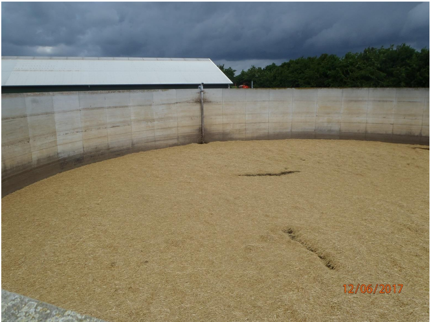
Billedet viser beholderen på 4500m 3 med tilstrækkeligt flydelag (snittet halm)
