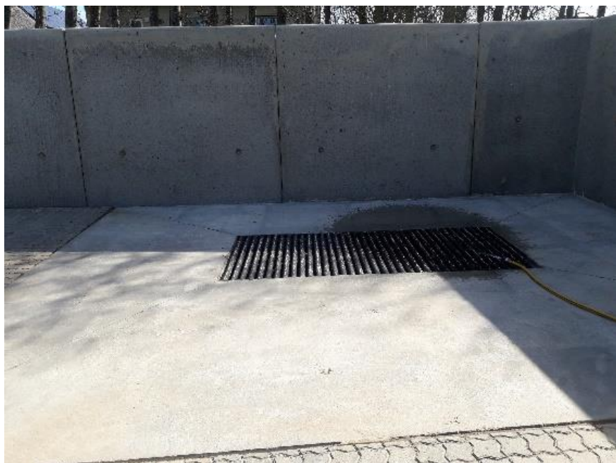
Vaskeplads med betonbelægning og med fliseareal udenom
