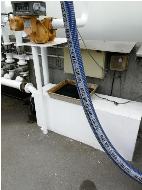
"spildebakke" ved tankgården.
