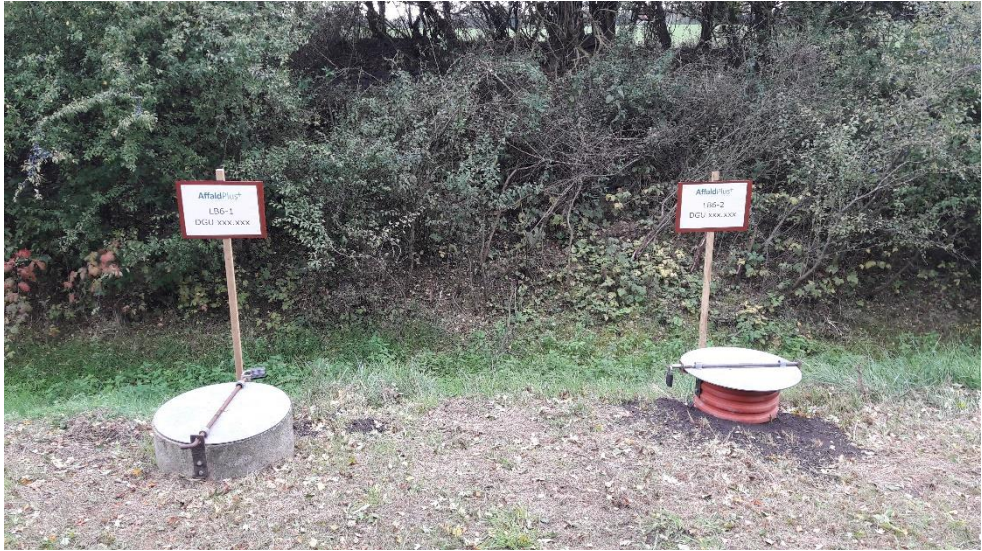
Aflåste grundvandsboringer med tydelig identifikation.
