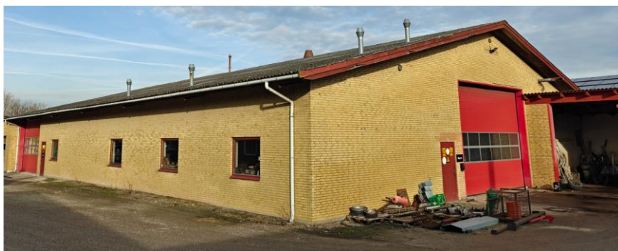
Smedeværksted med afkast fra punktudsug – i midten ses afkastet fra malerkabinen.
