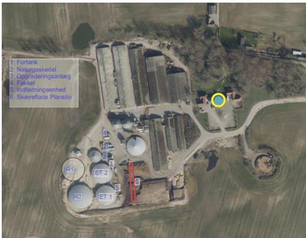
Figur 8.1 - Placering af lugtafkast på Zastrow Biogas.
