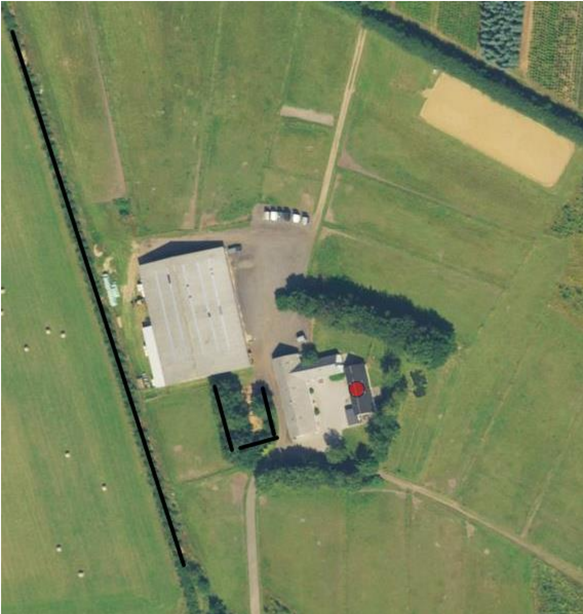
Figur 1. Sorte markeringer viser de læhegn der skal vedligeholdes.
