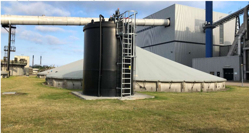
Figur 1: Billede af eksisterende fosfortank samt markering (blå) af placeringen af ny jernklorid-tank. Forventet placering af tanken kan ses på Figur 1 og Figur 2.
