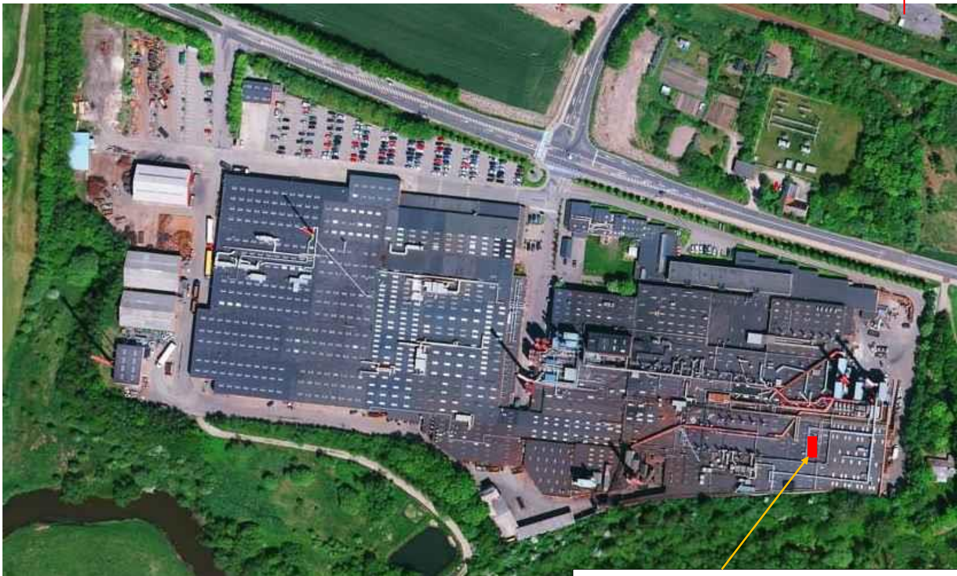
Placering af anlæg til knusning af indløb fra støbelinie 7
