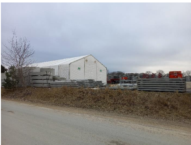
Figur 2. Telthal til behandling af elementer.
