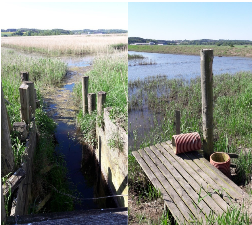
Foto 5: Sluse mod nordvest til venstre og mod nordøst til højre.
