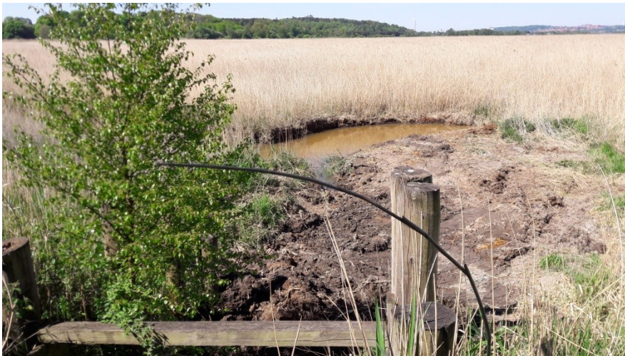
Foto 3. Jordvold foran sluse i nordøstlige hjørne.
