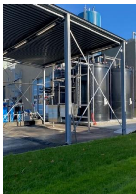
Figur 8. 3 udendørs dobbeltkappede tanke med koncentreret kemi (d)
