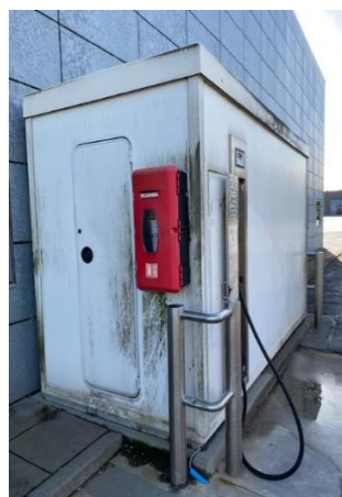
Figur 12. Dieselstander (t.v.) og Adblue tank (t.h.)
