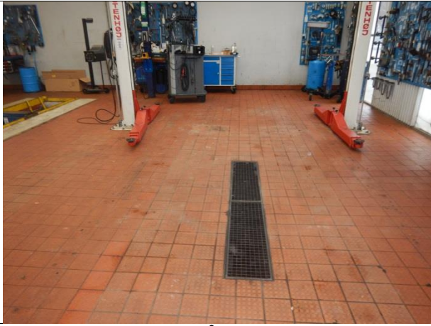
Foto 13: Sandfang i gulv på værkstedet.
