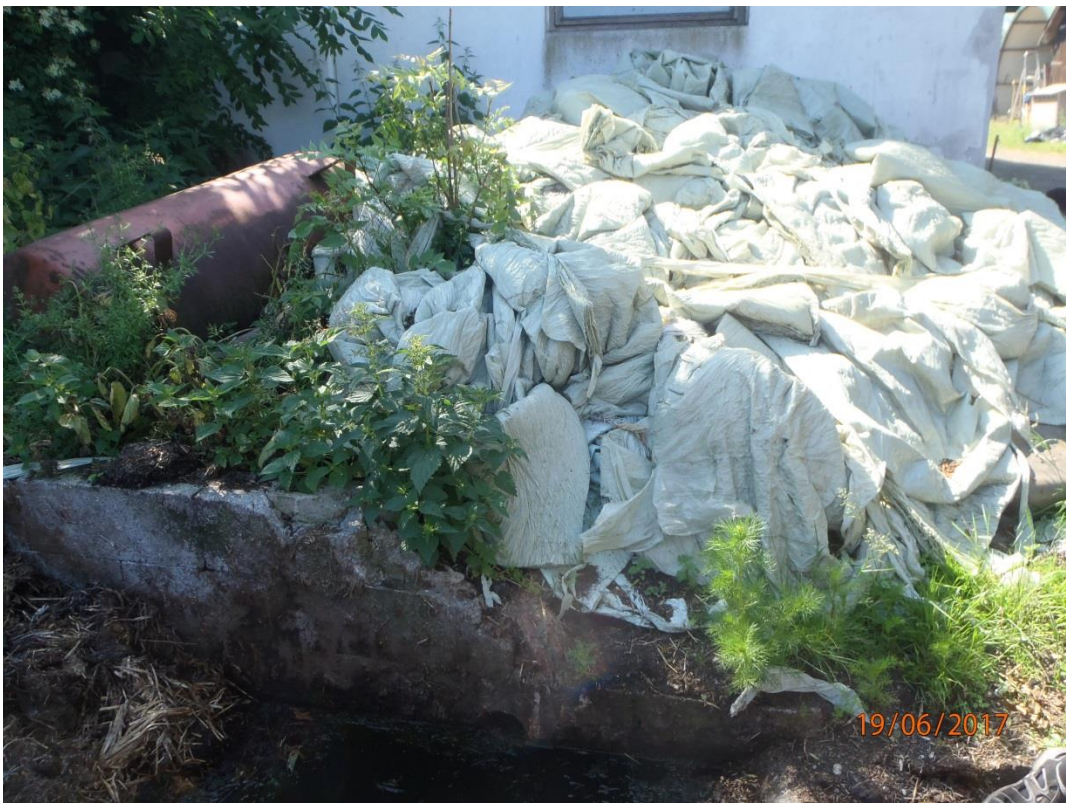
Billede viser afløb fra møddingspladsen til ajlebeholderen samt oplag af plast fra wrap baller øverst
