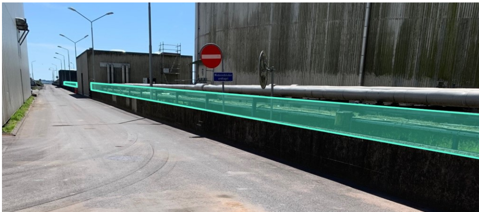
Figur 2 Forhøjelse af eksisterende tankgårdsmur
