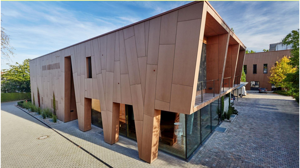
Figur 6 Facadeudseende med Paroc-plader, muligt udseende
