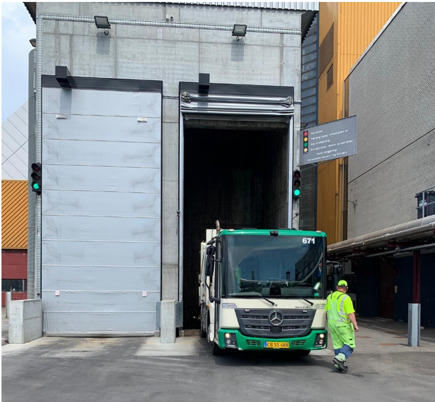
Billede 7: Komprimatorbil ved åben aflæsebas hos AffaldPlus
