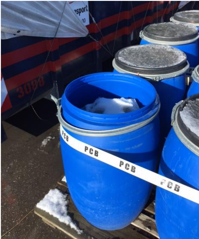
Foto 2: Tønder med PCB-affald, et låg mangler
