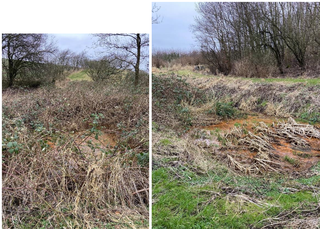
Figur 3 Sedimentationsbassiner til overfladevandet inden udledning til Visby Å. Bassinerne trængte kraftigt til en oprensning.
