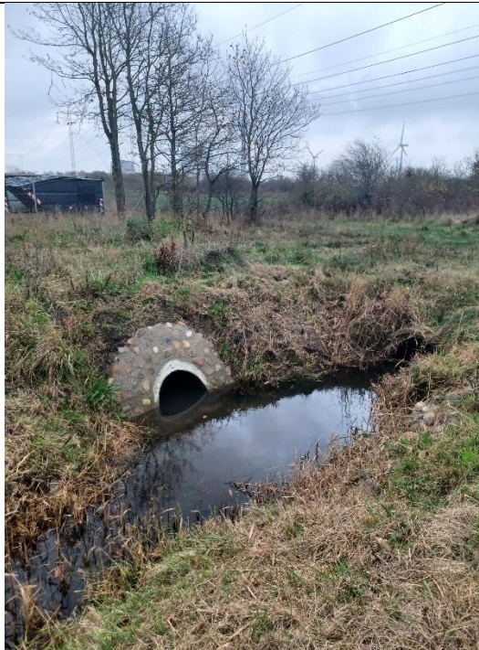
Udløbet af det nye rørlagte vandløb i Afvandingsgrøften Horsensenge
