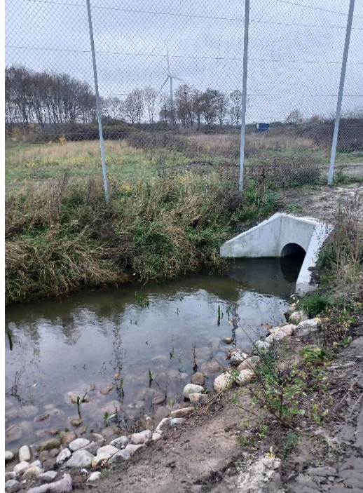
Indløbet ved HP2 til det nye rørlagte vandløb
