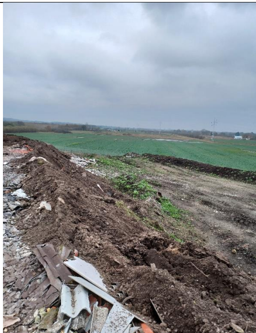
Kanten af asbestdepotet med "hylden" efter tilbagetrækning af deponikanten
