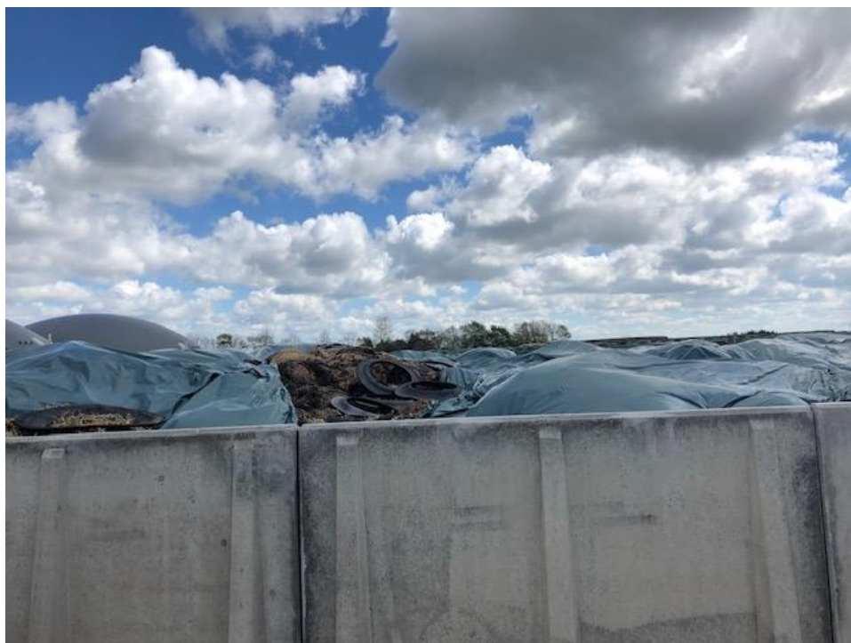
Internt oplag af dybstrøelse til biogasanlægget i plansilo (d. 13. maj 2019)
