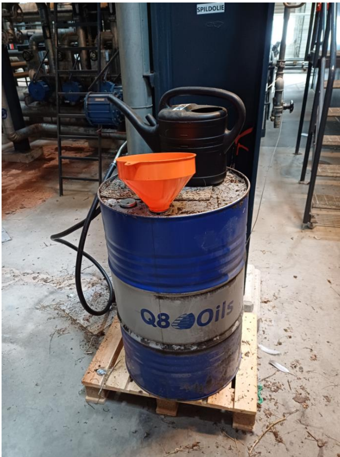
Foto 6. Beholder med spildolie uden spildbakke. Beholderen er placeret indendørs.
