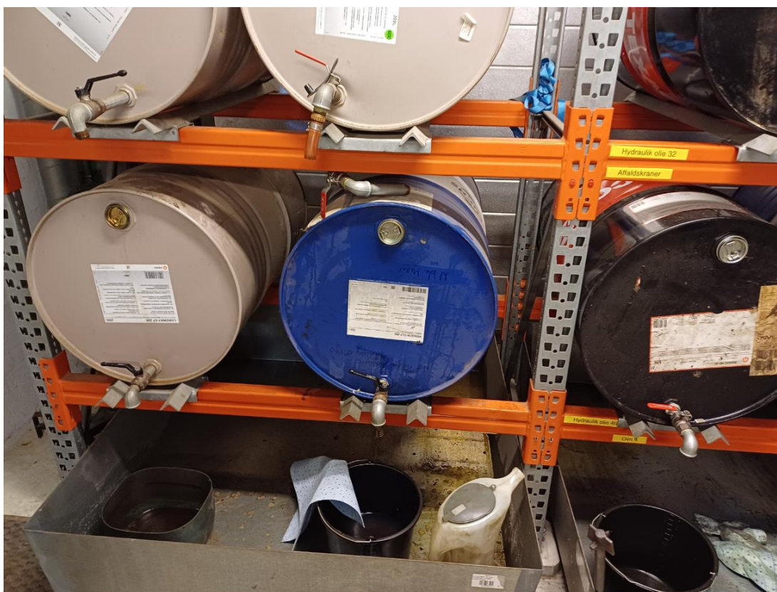
Foto 2. Spildbakke under aftapningshaner i kemirum.
