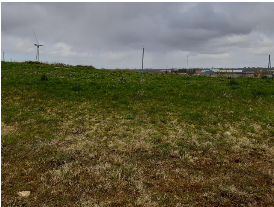
Figur 4. Biocover. Dele af vegetationen visner/brunt.
