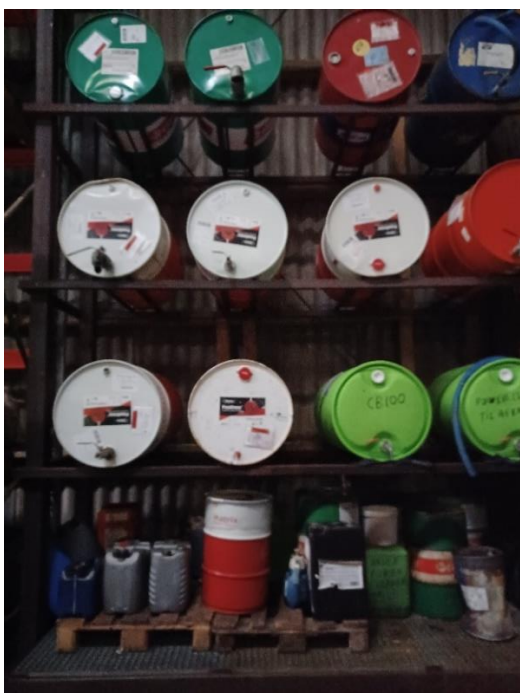
Oplag af olie og andre miljøfarlige flydende stoffer placeret i det gamle sorteringsværksted.
