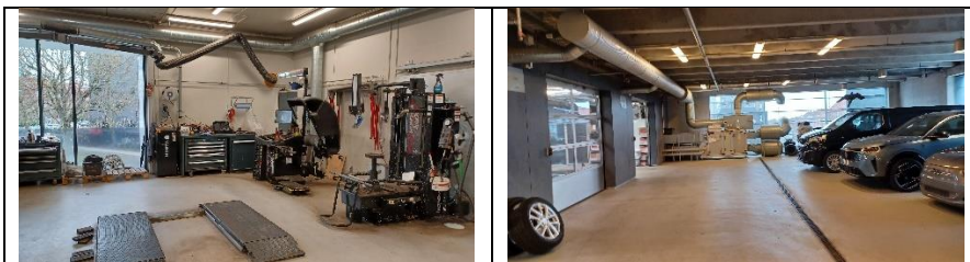
Der skiftes dæk, ventilation er ført over tag
