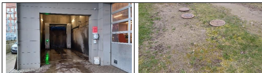
Vaskehal med olieudskiller beliggende i græsplæne.
