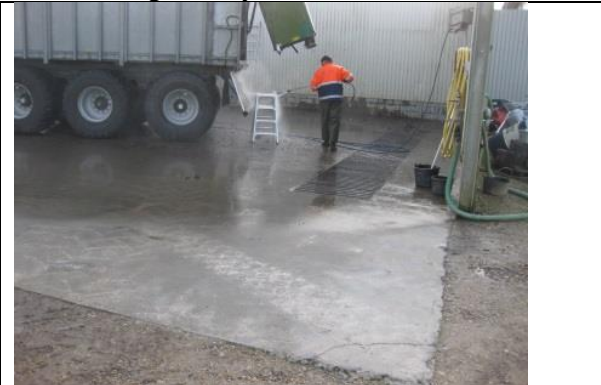
Vaskeplads med afløbsrist og tapsted for slangevask
