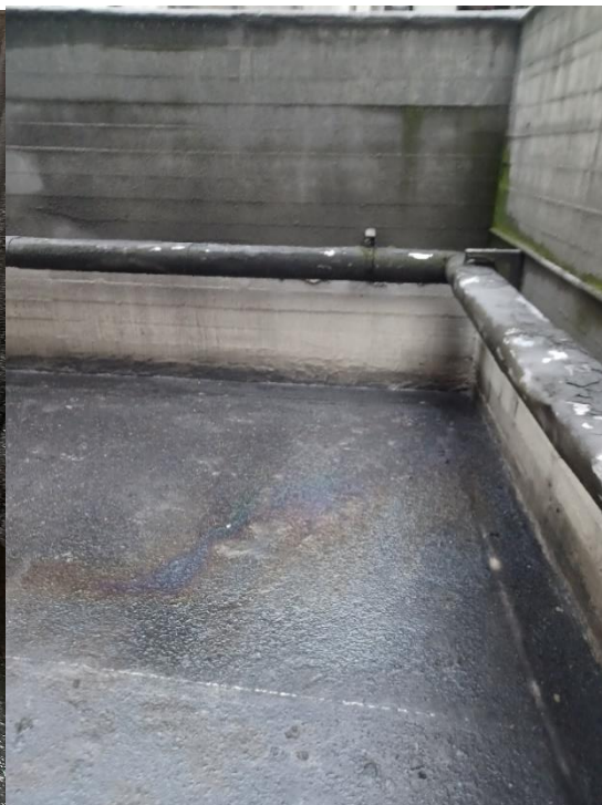
Opsamlingskar med spildolie (venstre) og spildte olieprodukter i tankgård (højre).
