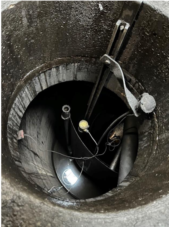
Brønd med metaltank i bunden ved forvarmerstation
