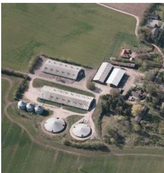
Figur 3 Saltoftevej 2 og 3 set fra Nord. Kilde: skråfoto.dk
