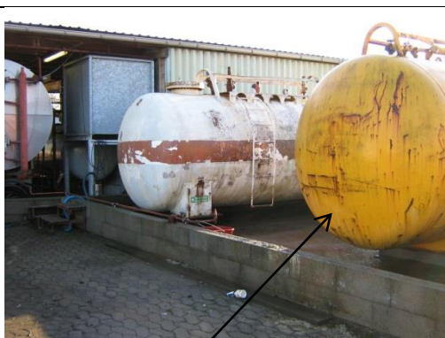
Billede nr. 4: Tank nr. 4 der var fjernet ved tilsynet i 2013. (2010)
