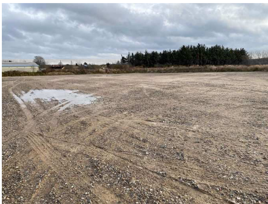
Foto 1: mellemoplag ved matr.nr. 2x, Skalborg By, Skalborg ved opstart
