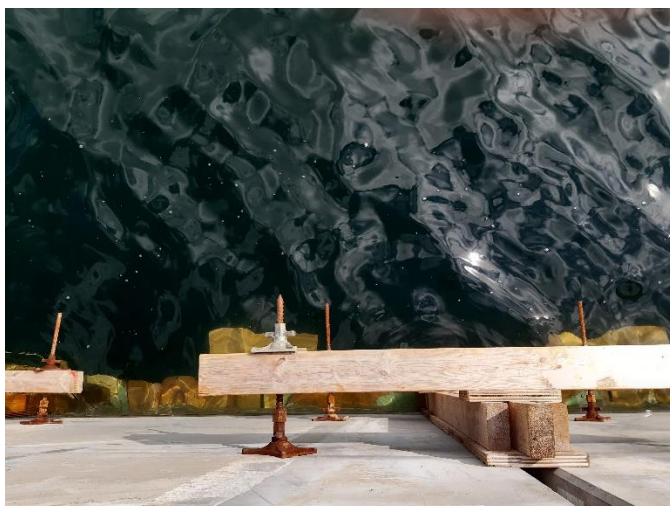
Opbygning af betonbeklædning foran spunsen.
