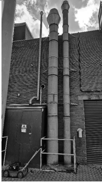
Foto 5 Afkast til venstre er fra slibeprocesser, der har været gennem cyklonfilter. De to andre afkast er ikke i brug.
