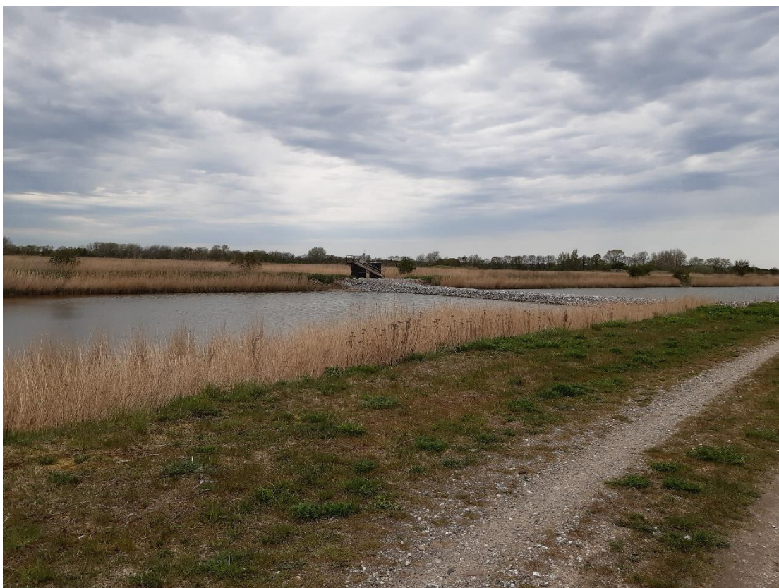
Foto 15: Nyt overløbsbygværk, som forbinder sidste sedimentationsbassin i vandrenseområdet med udløb til Odense Kanal. Desuden ses vandrenseområdets indledende stenfilter, som vandet passerer fra syd mod nord.
