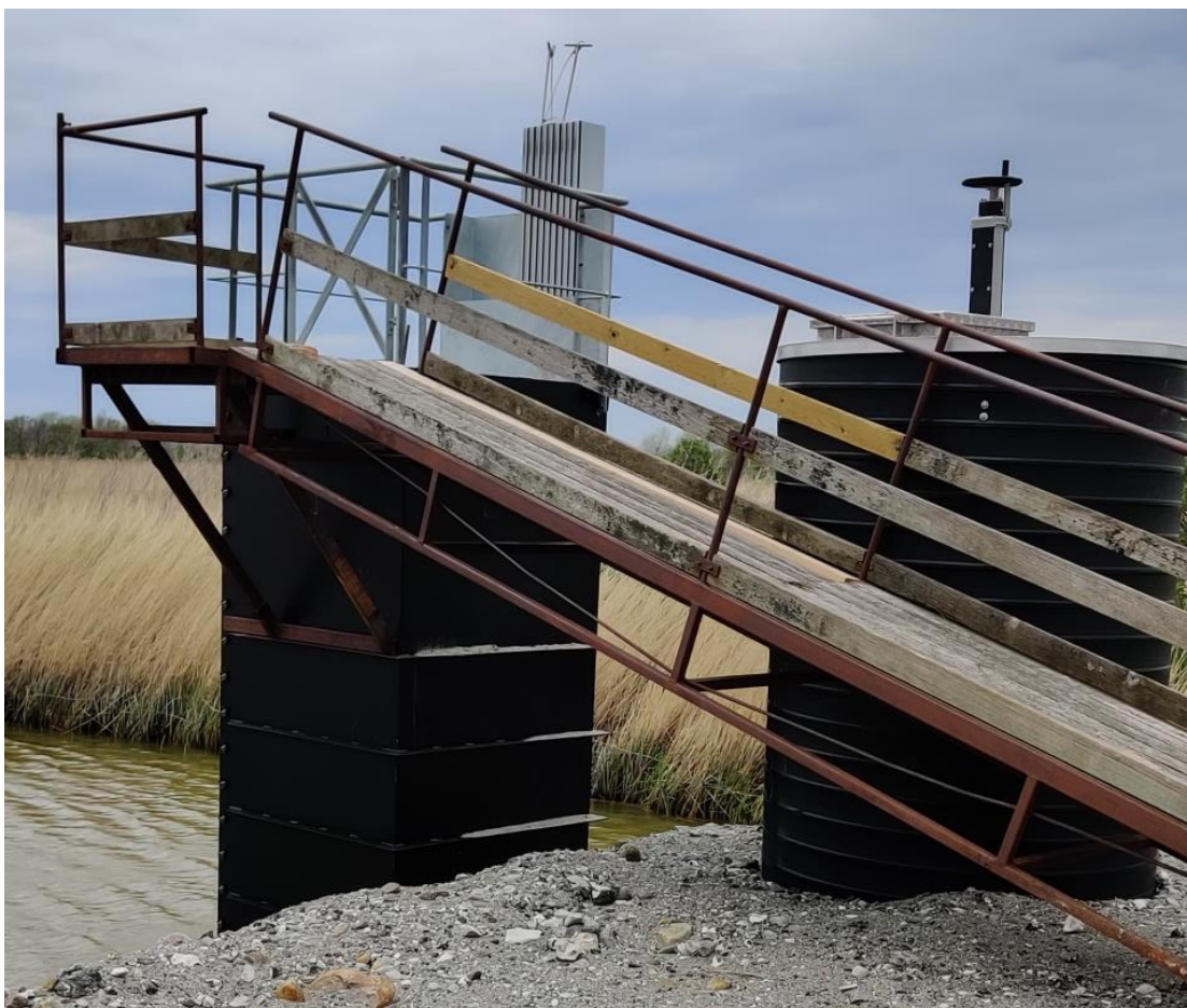
Foto 16: Nyt overløbsbygværk etableret i vandrenseområdets sidste sedimentationsbassin.
