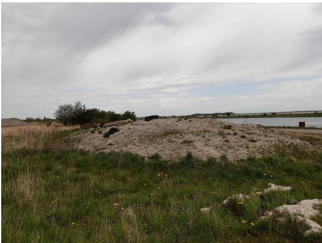
Foto 10: Bunke af frasorterede materialer, som ikke er optaget på deponiets positivliste, og derfor løbende fraføres deponiet.
