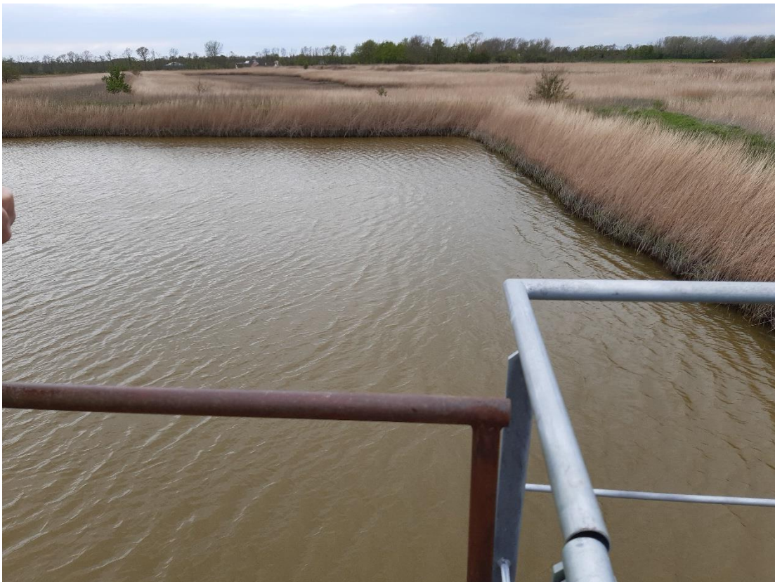
Foto 19: Udsyn fra overløbsbygværk i retning mod vest. Forrest ses sedimentationsbassin, bagerst ses vandrenseområdets sandfiltre.
