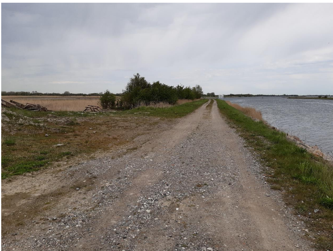
Foto 11: Øststlige dige langs Område Syd. Til højre ses Odense Kanal. Til venstre ses bunken af frasorteret materiale, som ikke er optaget på deponiets positivliste.
