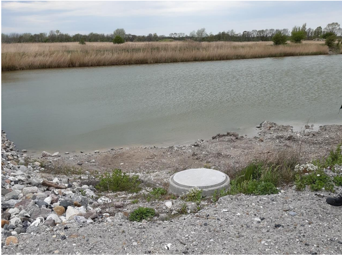
Foto 18: Brønd etableret mellem overløbsbygværk og udløb til Odense Kanal. I brønden vil der blive indrettet prøvetagningssted.
