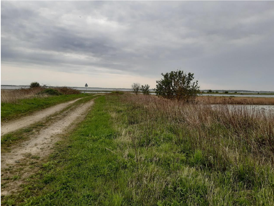
Foto 22: Dige, der adskiller vandrenseområdet (til højre) fra Område Nord (til venstre), set i retningen fra vest mod Odense Kanal.
