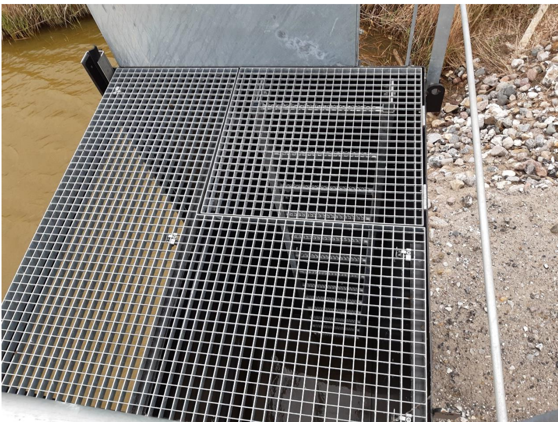
Foto 17: Kig ned i overløbsbygværk. Højden af overløbet reguleres med metalplader.
