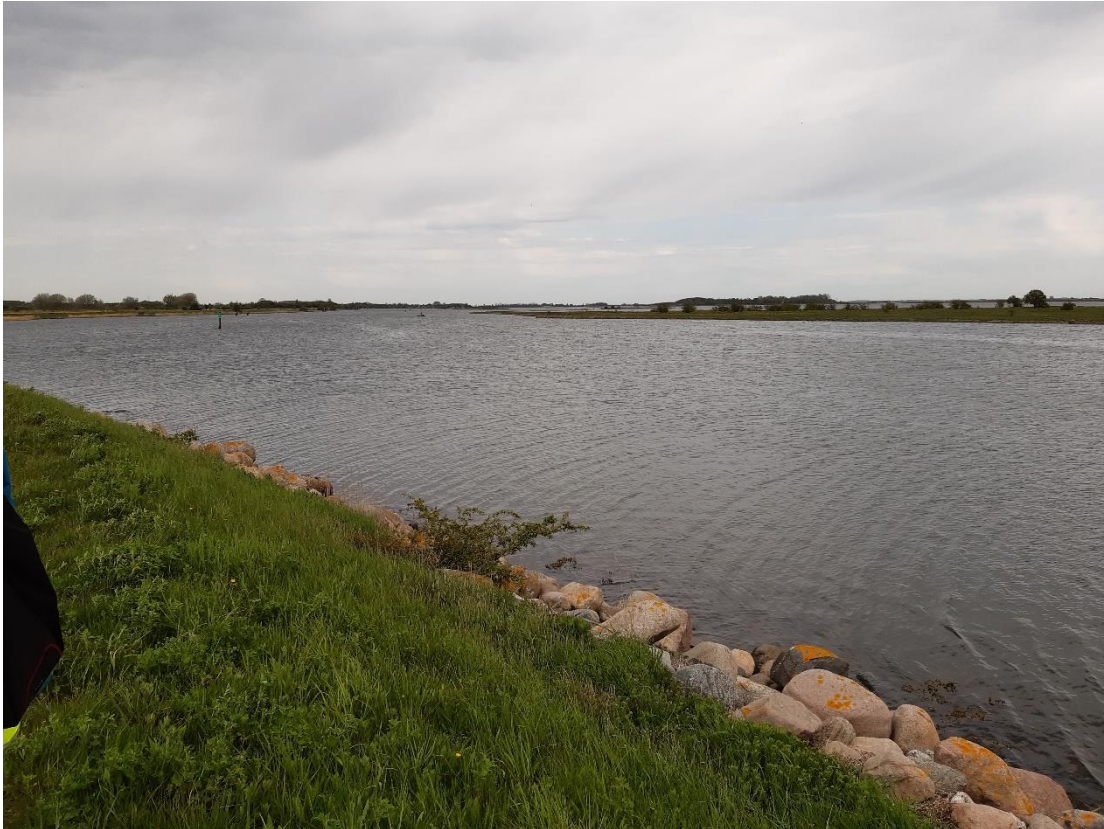
Foto 12: Stensætning langs østlige dige mod Odense Kanal.
