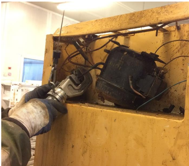
1. Klipning af kobberør
