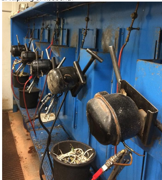
3. Tømning af CFC og olie med vakuum
