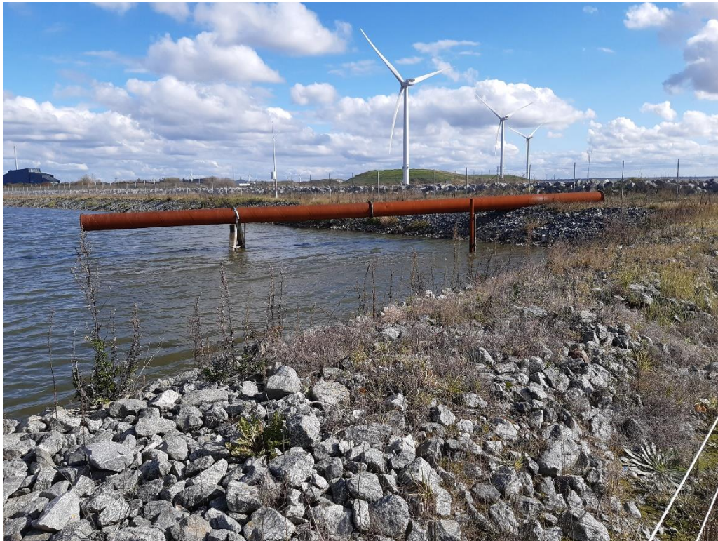
Foto 14: Billede af permanent ende af indspulingsrør i deponiets sydøstlige hjørne. Billedet er taget fra det sydvestlige dige i retning mod nordøst. Foran indspulingsrør ses fast målepind til aflæsning af vandstand.
