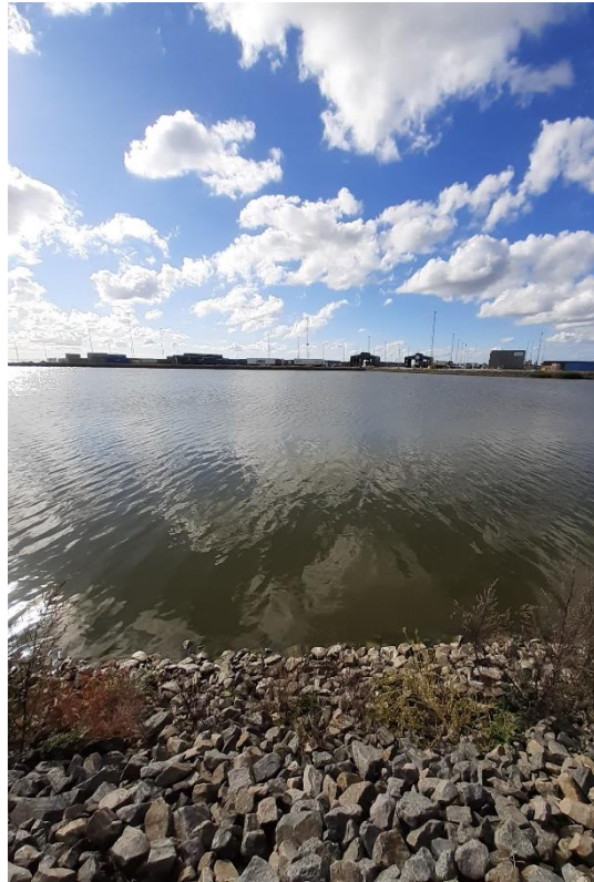
Foto 9: Stensætning langs indersiden af det nordøstlige dige. Billedet taget fra diget i retning mod deponiets sydvestlige hjørne.
