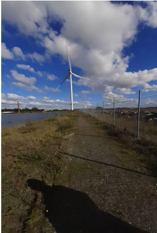
Foto4: Deponiets sydøstlige dige, der grænser op mod Vadehavet. Billede taget fra sydøstlige hjørne mod nord.
