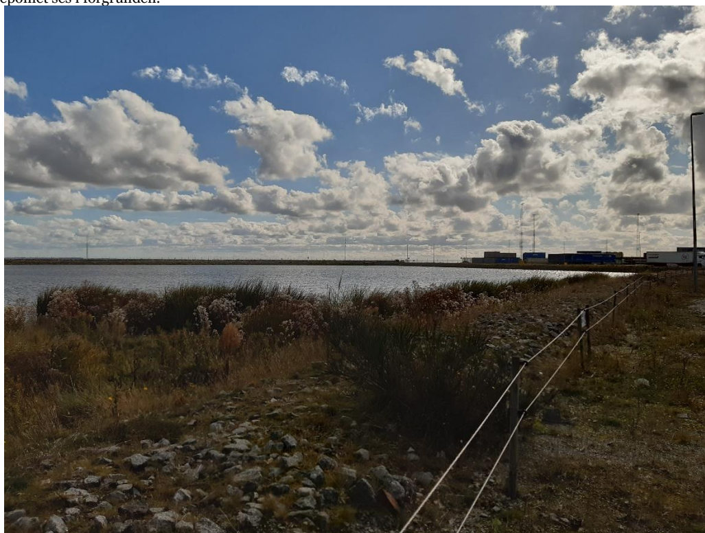
Foto 3: Trådhegn langs deponiets vestlige dige, som grænser op mod havneareal.
