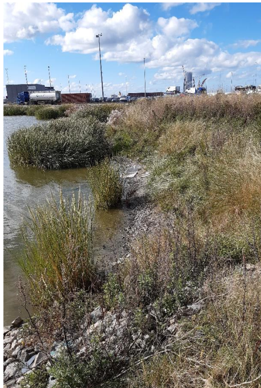
Foto 11: Indersiden af deponiets nordvestlige dige, hvorfra der er mulighed for deponering via dumper. Billede taget fra deponiets nordligste hjørne i retning mod sydvest.
