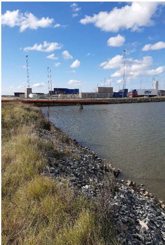
Foto 6: Stensætning langs indersiden af det østlige dige, hvor der er udført ridser i tekstildug. Billede taget fra østlige dige i retning mod havneareal syd for deponi.
