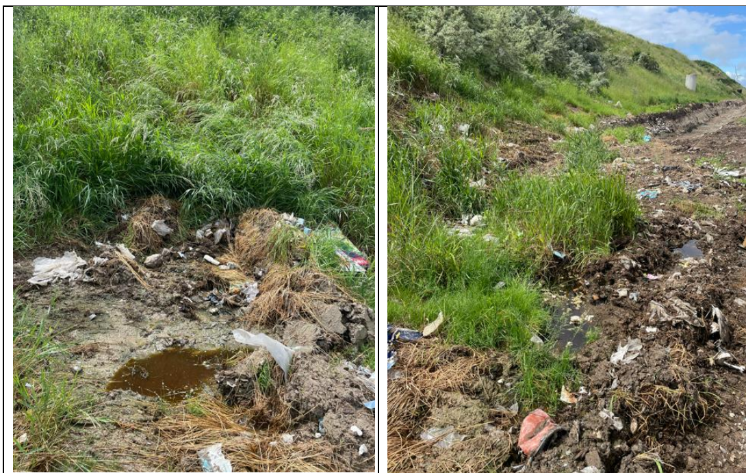
Figur 25. Der sås udtrædende perkolat fra de dele af enheder 1 og 4 som var skredet ud over membranlagt areal.
