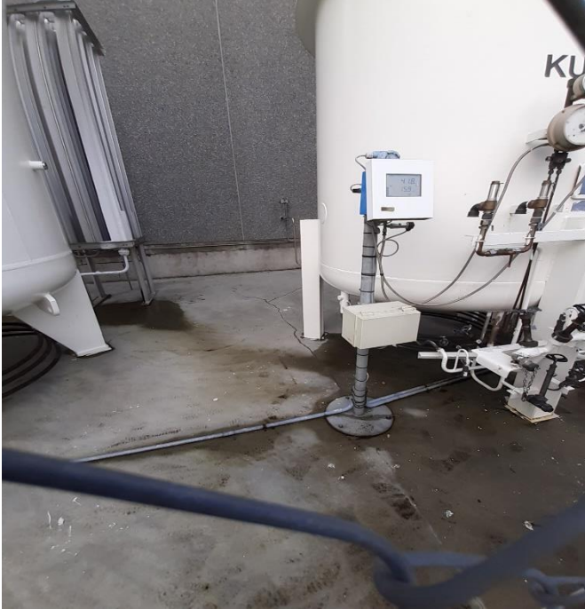
I belægningen ses små revner, hvilket er i strid med godkendelsens vilkår
