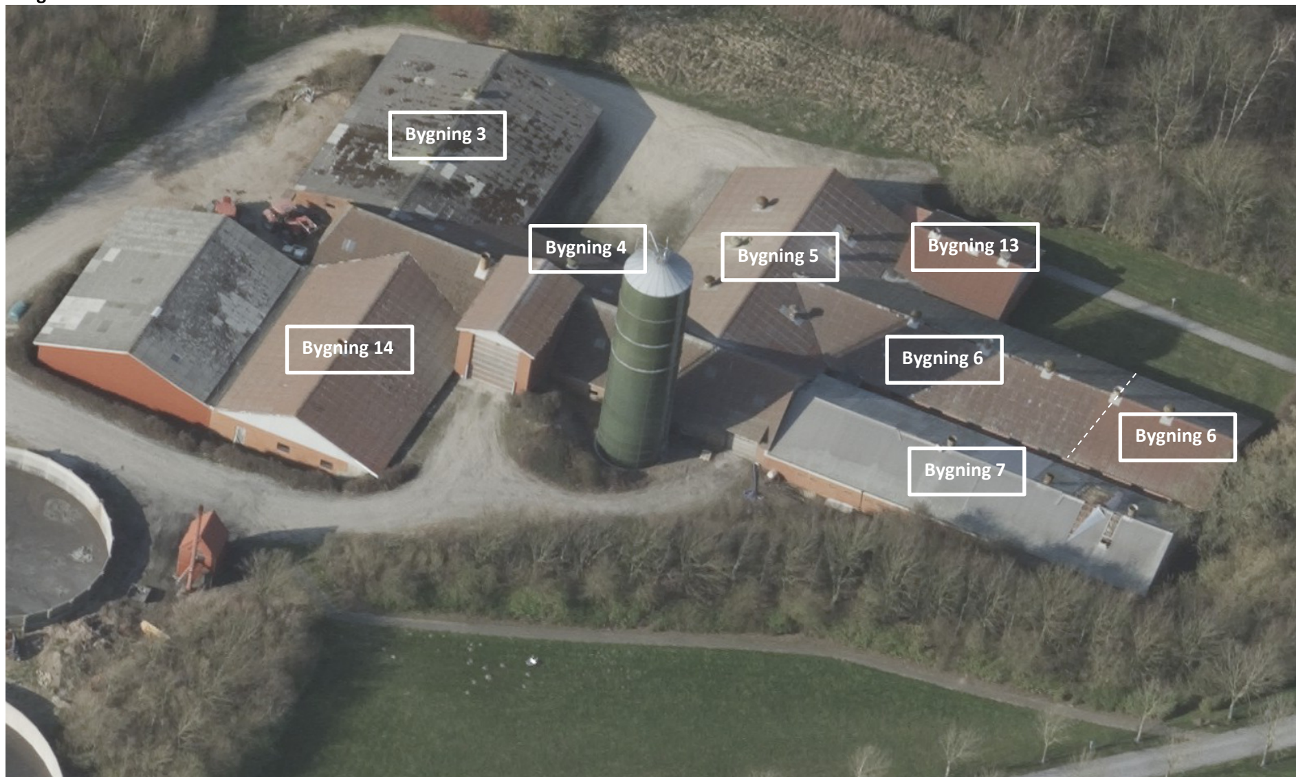
Skråfoto af Remmervej 7 fra 2021 [kilde:skraafoto.dataforsyningen.dk]. Bygningsnumre henviser til nummerering i BBR.
