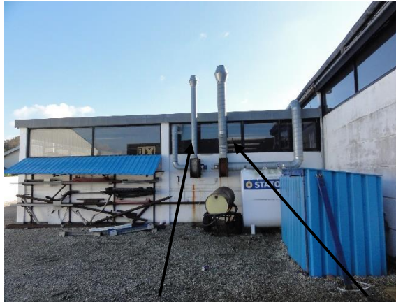
Billede nr. 1 – Afkast nr. 2 (pladeværksted) og afkast nr. 1 (udstødning)
