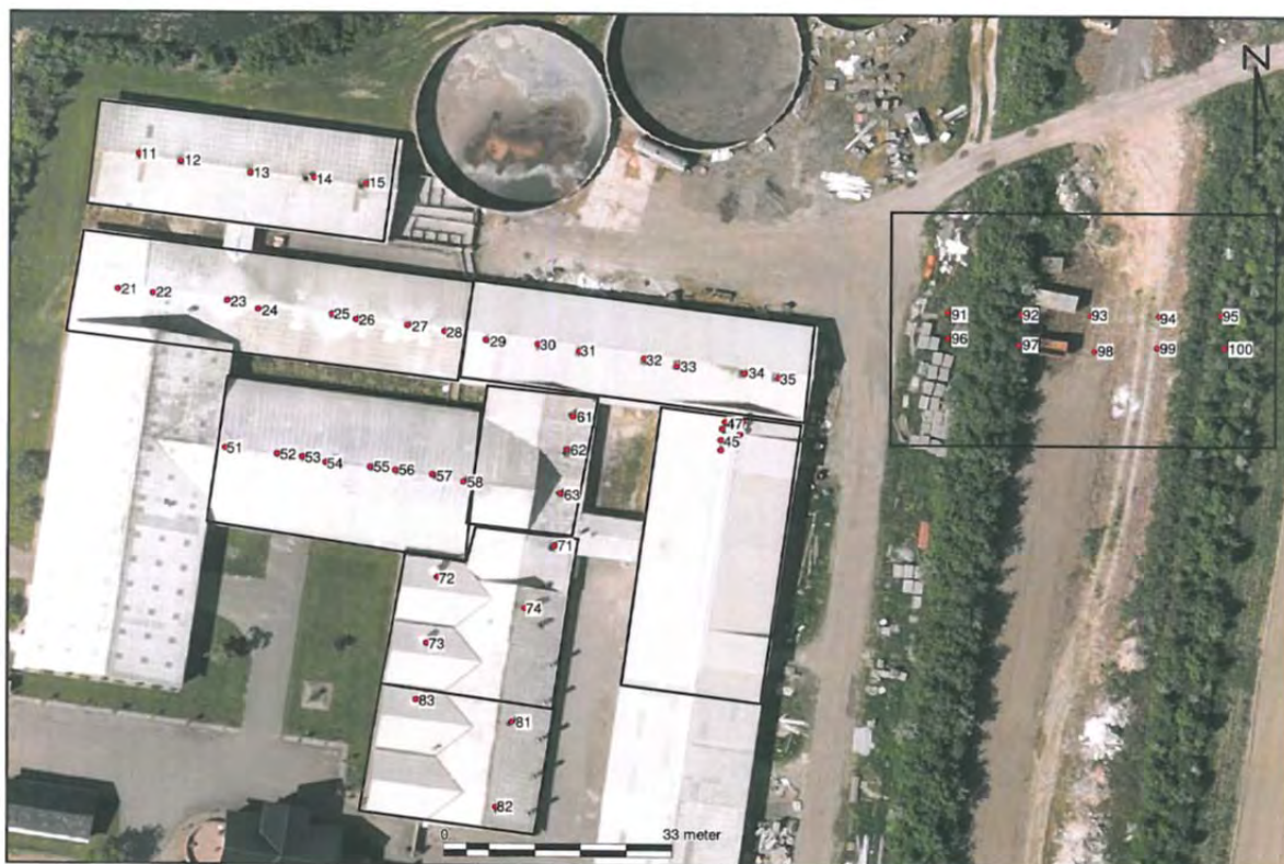
Kort 4.3.1 – Placering af ventilationsafkast (numrene er i relation til beregning af lugt fra anlægget)
