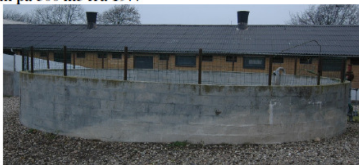
Bygning 6. Gylletank på 300 m 3 fra 1977
