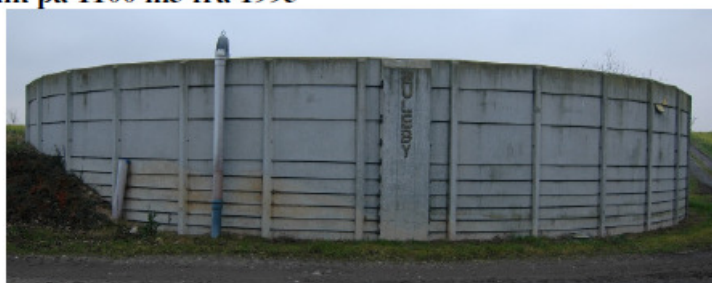
Bygning 7. Gylletank på 1100 m 3 fra 1995
